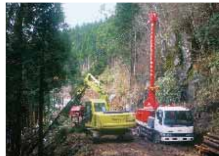
主索式タワーヤードとプロセッサ作業システム プロセッサが入り込めるスペースが必要
