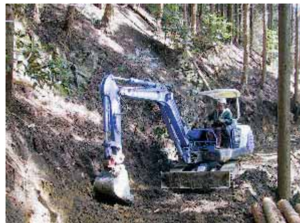
林内作業車道( W=2m )の開設状況 切取法高を低く開設することが重要
