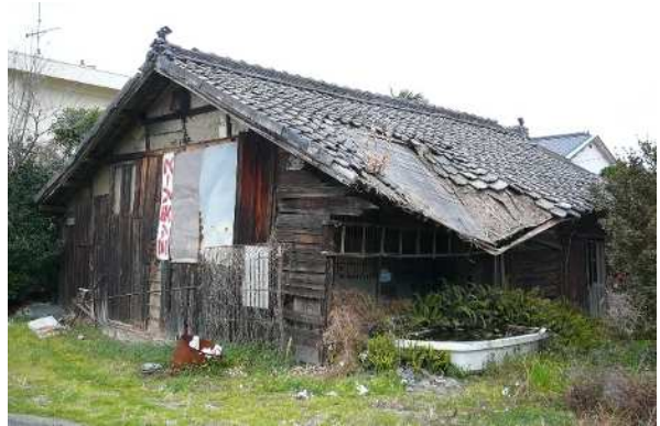
放置された空き家
