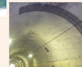
トンネル壁面の補修
