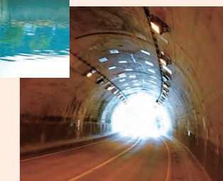
トンネル壁面の補修
