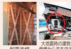
耐震改修(筋かい追加) 大地震時の建物倒壊から命を守る耐震シェルター
