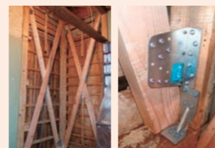
補強例:筋かい追加・接合金物追加
