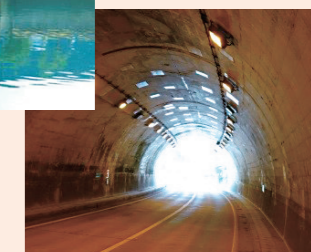
トンネル壁面の補修
