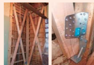
補強例:筋かい追加・接合金物追加
