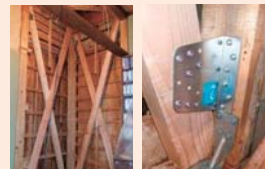
補強例:筋かい追加・接合金物追加
