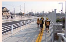
(主)壬生川丹原線(西条市)
