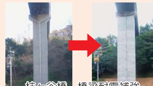
柿ヶ谷橋 橋梁耐震補強 (一)鳥井喜木津線(伊方町)
