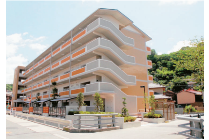
県営住宅明倫団地(宇和島市)
