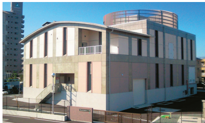
朝生田雨水排水ポンプ場(松山市)
