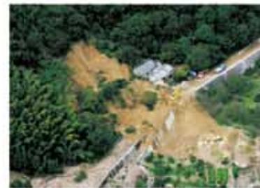
平成16年台風21号被害状況
