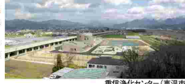
重信浄化センター(東温市)
