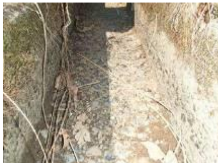
整備前（水路状況）
