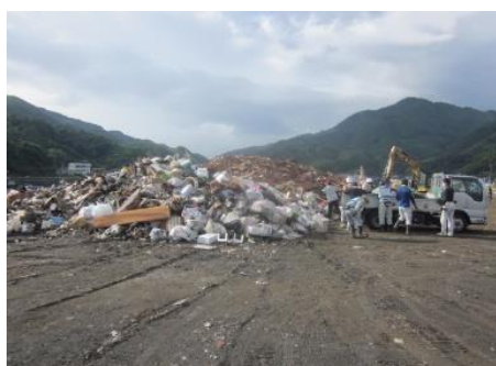
がれき仮置き状況
