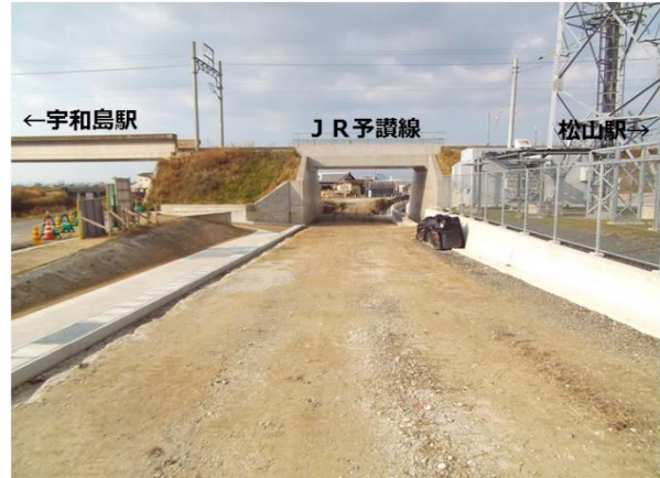
(平松第二架道橋)
