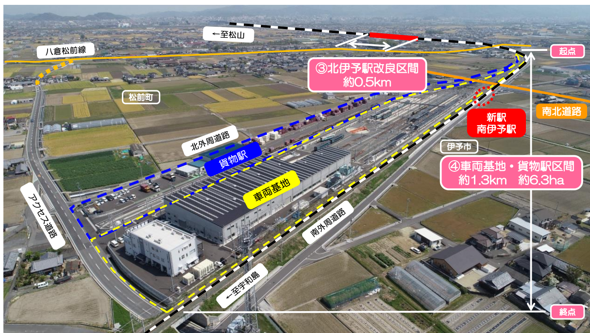
【車両基地・貨物駅区間の航空写真】
