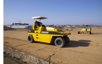
(締固め状況)
