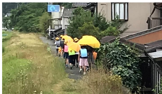
現道が狭いため小田川管理用道路を利用 (転落防止柵・街灯なし)
