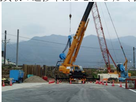
【JRアンダー部の工事状況】
