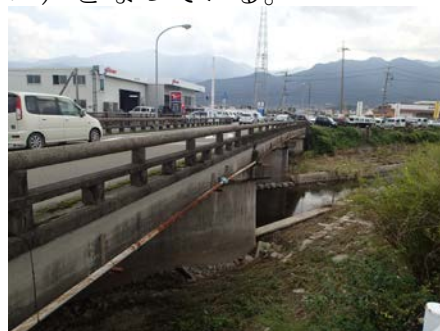
【追加区間橋梁状況 S36年架設】
