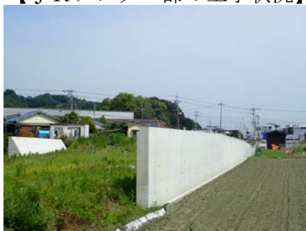
【路側擁壁の設置】
