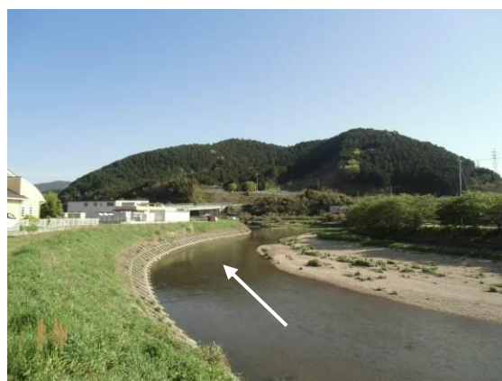
写真4-6 未整備状況 終点SP 4700 付近下流
