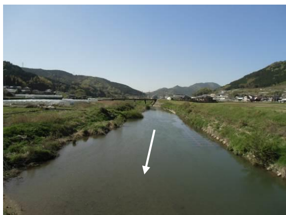
写真4-3 未整備状況 SP 2100 付近前の瀬橋上流
