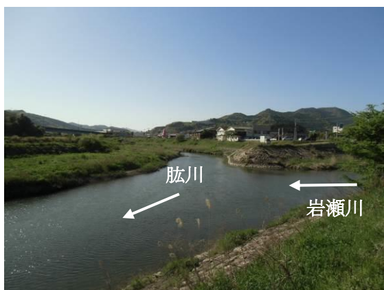
写真4-5 未整備状況 SP 4200 付近岩瀬川合流部対岸
