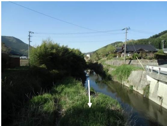
写真4-9 未整備状況 SP920付近福吉橋上流
