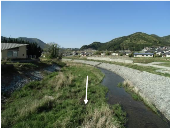
写真4-7 整備状況（完成改修済み） SP0付近新道義橋上流
