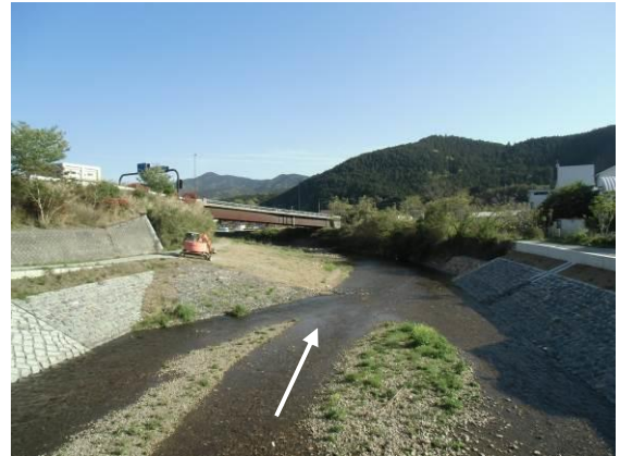
写真4-8 整備状況（左岸暫定、右岸完成改修済み） SP420付近道義橋下流
