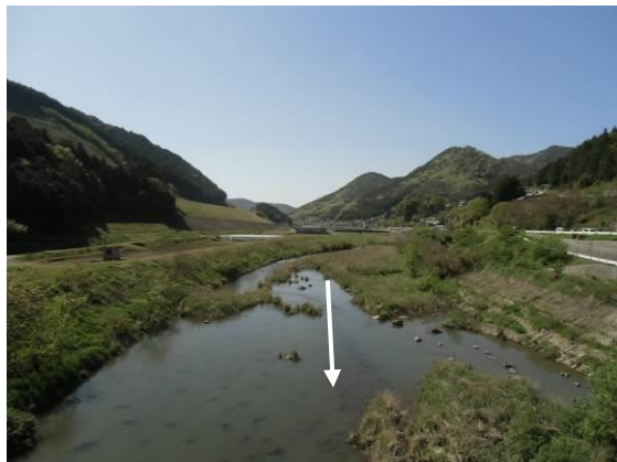
写真4-1 整備状況 (完成改修済み) SP 145 付近歯長橋上流
