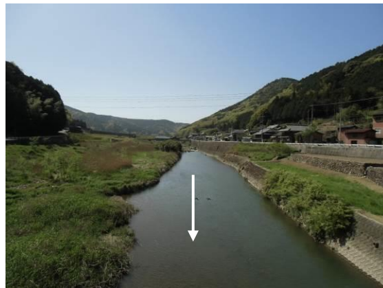
写真4-2 整備状況 (右岸暫定改修済み) SP 900 付近下川橋上流
