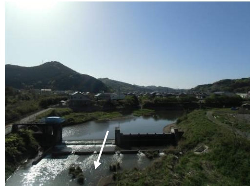
写真3-9 河川周辺平坦地の宅地化
