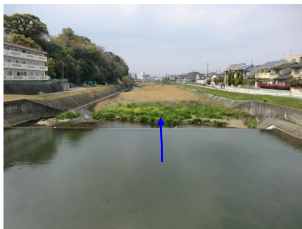
写真 3-6 流域写真 (R1 ブロック)
