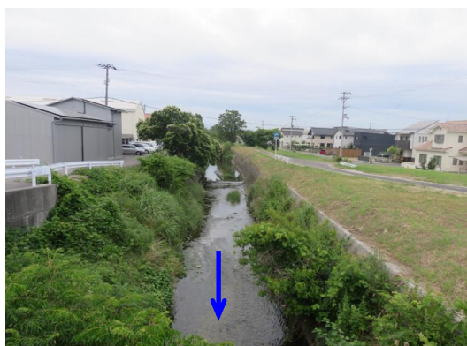
写真 2 - 3 SP 2 0 6 0 付近の現況写真
