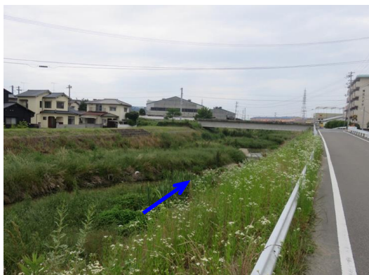
写真 2 - 1 SP 1 6 0 0 付近の現況写真
