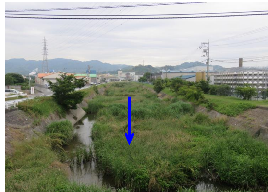
写真 2 - 2 SP 1 0 0 0 付近の現況写真
