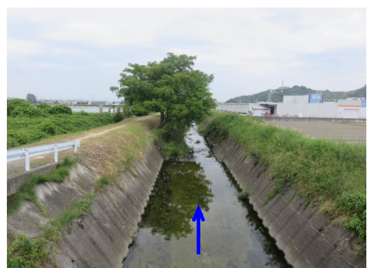
写真 2 - 4 SP 2 6 0 0 付近の現況写真
