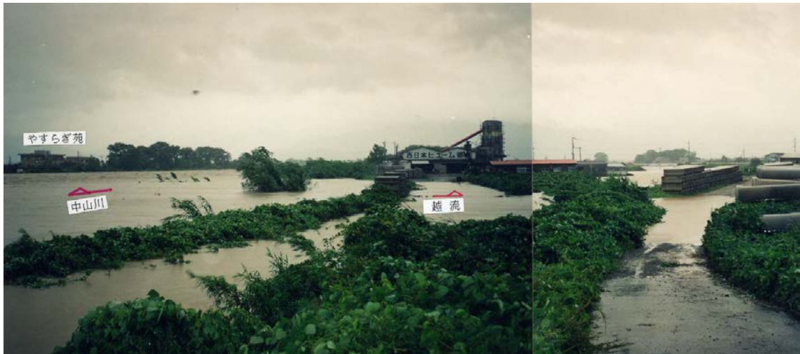
写真 3-3 浸水被害 (4k000 付近左岸)
