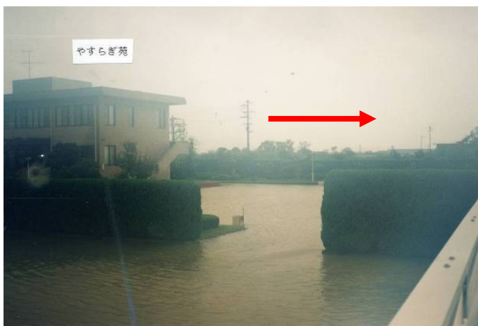
写真 3-5 浸水被害 (4k000 付近右岸)
