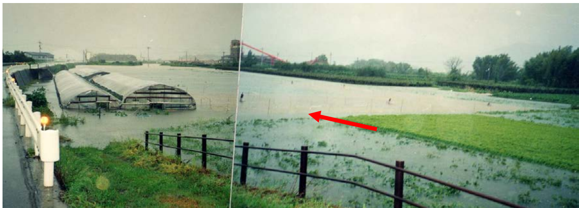
写真 3-4 浸水被害 (4k000 付近左岸)
