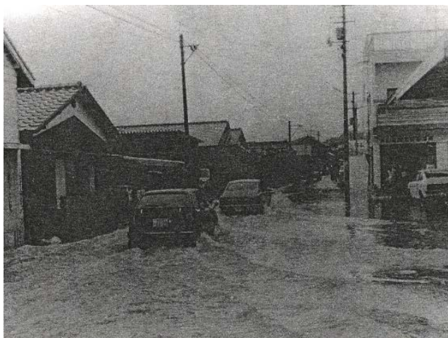
写真 3-1 床上浸水被害 ((旧)丹原町)
