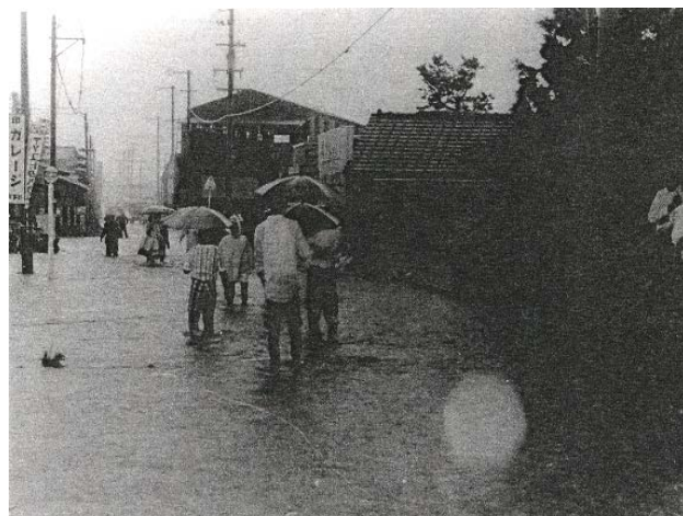
写真 3-2 床上浸水被害 ((旧)丹原町)
