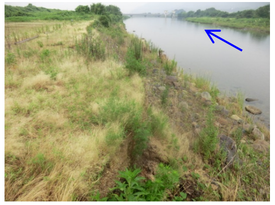
写真 4-2 未改修区間 (右岸) の写真(11.6km 付近)
