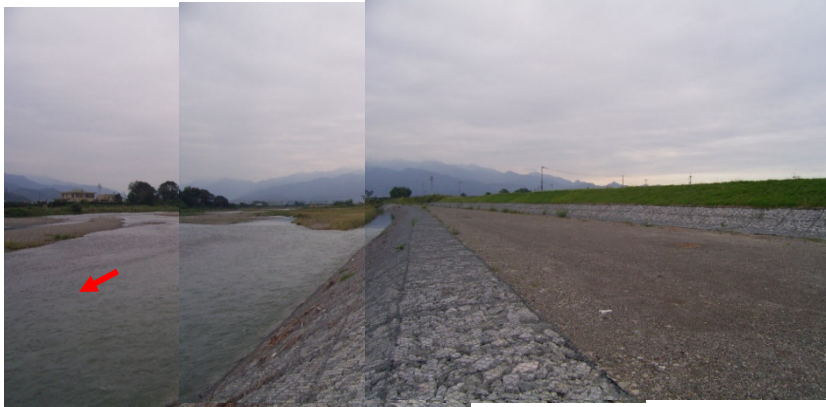
写真 4-1 改修済区間の写真(4.0km 付近)
