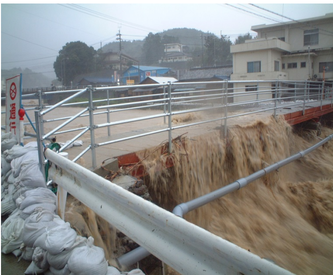
写真 3-5 被災状況 (5K200 付近)
