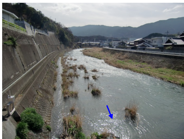
写真 4-4 整備状況 (3K600 付近)
