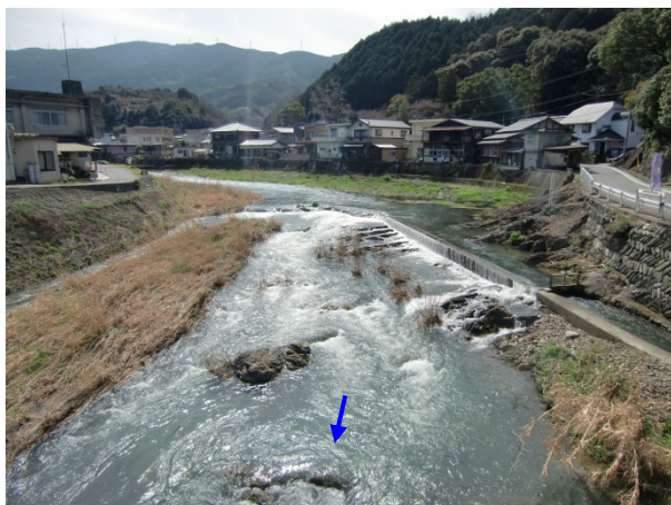
写真 4-1 未整備状況 (5K400 付近)
