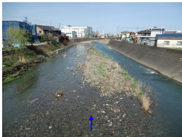
写真 4-2 整備状況 (3K000 付近)
