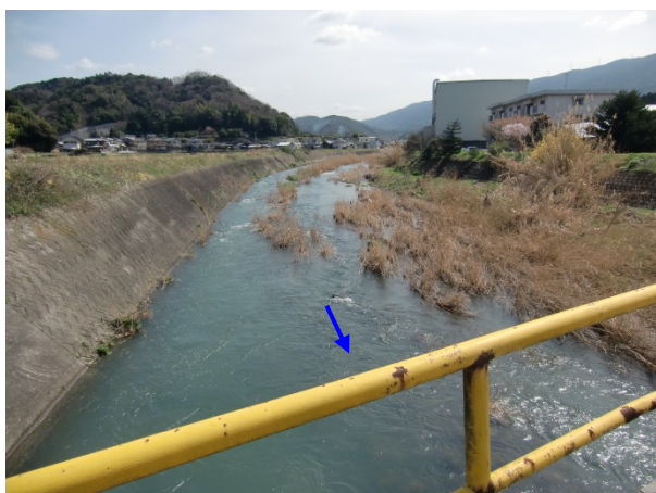
写真 4-3 未整備状況 (4K900 付近)
