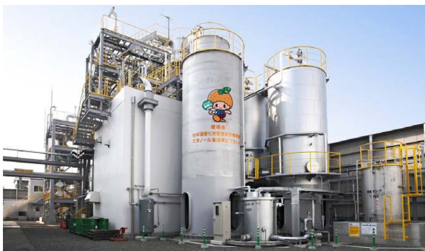
バイオエタノール製造実証プラント (みかん搾汁残さから得られる脱汁液 100 m 3 /日からエタノール 5 kℓを製造)
