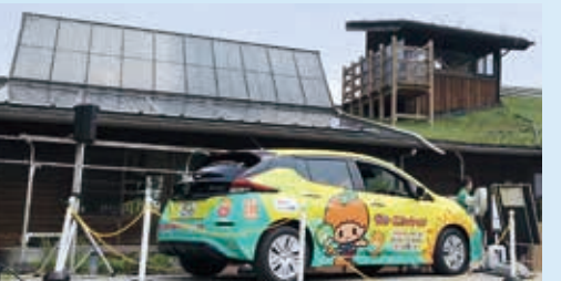
EV活用型蓄電システム
