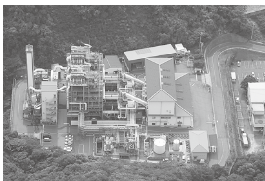
愛媛県廃棄物処理センター
