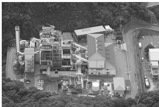
愛媛県廃棄物処理センター
