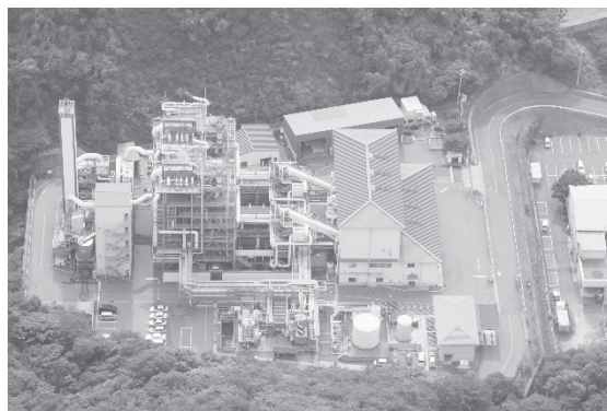
愛媛県廃棄物処理センター
