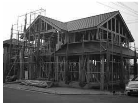
業 (えひめ産材を使用した展示住宅の建設)
