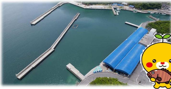
深浦漁港は、近い将来、発生が予測されている南海トラフ地震発生後の避難・緊急輸送物資の輸送等の防災拠点漁港として位置付けられていて、背後地域の被害軽減や発災後の地域水産業の早期再開を図るため平成 26 年から耐震強化岸壁への改良、防波堤の耐震・耐津波強化対策を実施しているきゃん。
