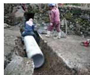
協働作業による水路補修
