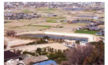
ため池の改修
