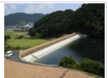
改修されたため池
