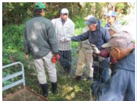
地域ぐるみで防護柵を設置
