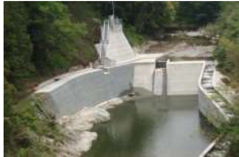
取水堰の改修
