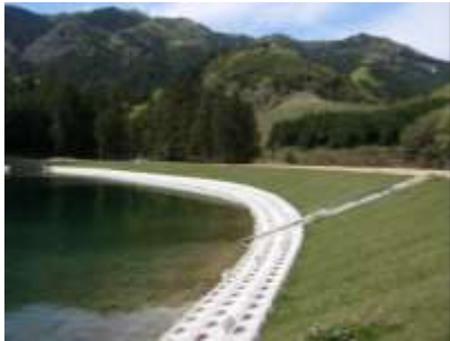
ため池の改修
