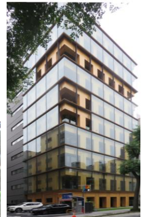
県産 CLT が使用された 11 階建て純木造ビル
