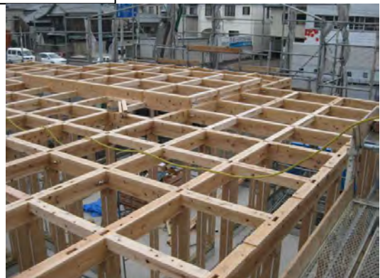
県産材の使用状況(建築中の状況)
