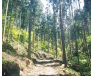
作業道の整備
