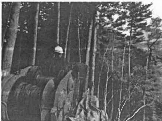
架線による搬出作業（四国中央市）
