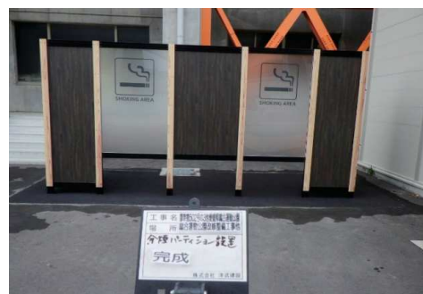
木質パーティションの設置
