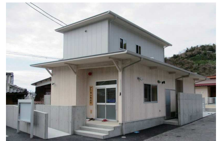
西予警察署高山駐在所の新築整備
