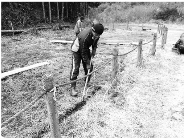
図11 水路の浚渫の様子
