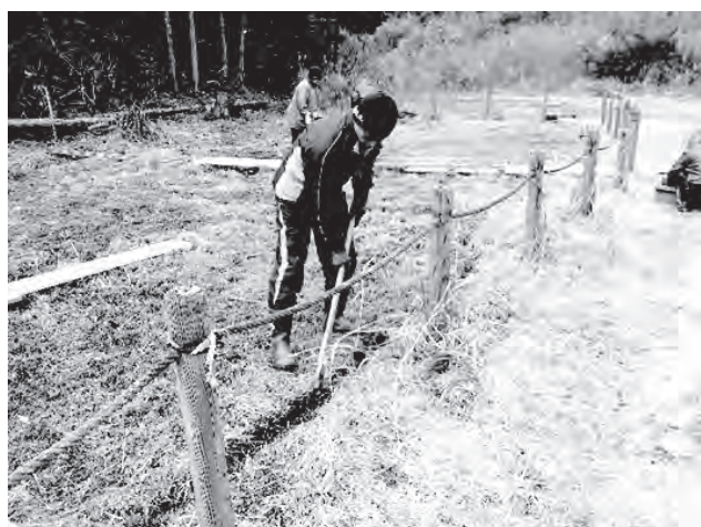
図11 水路の浚渫の様子
