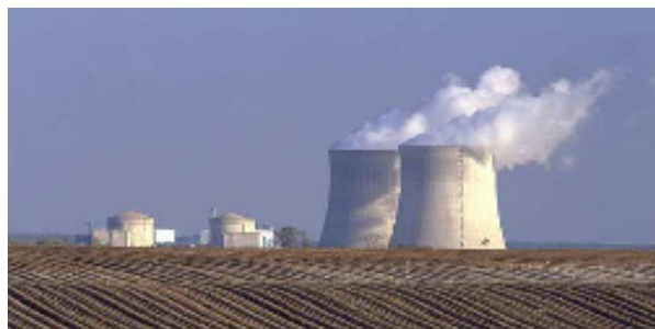
発電所と冷却塔
