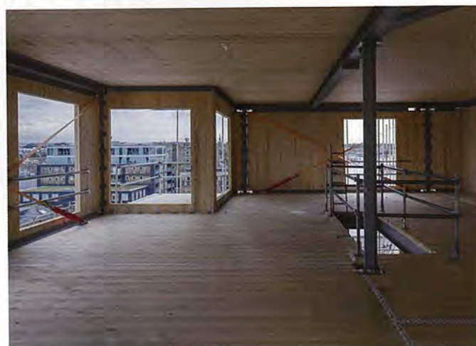
建設中のマンション(イギリス ロンドン)。鉄骨造の壁や床材としてCLTを利用 写真: http://www.ribaj.com
