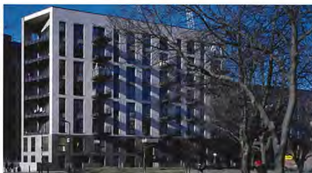
Bridport house(イギリス ロンドン) 8階建て(1階~8階までCLT構造) 写真: http://www.bdonline.co.uk/
