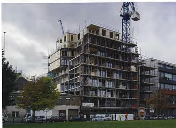
建設中のマンション(イギリス ロンドン)。鉄骨造の壁や床材としてCLTを利用 写真: http://www.ribaj.com
