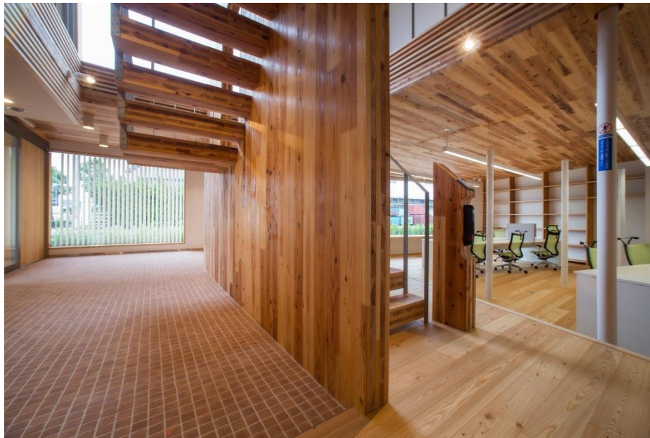
県内初の CLT を用いた建築物
