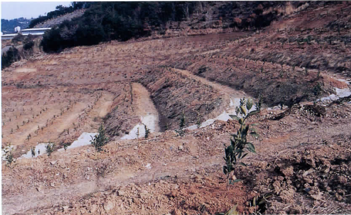
傾斜地園の基盤整備
