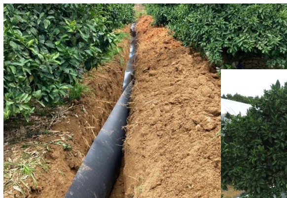
NARO S.シート埋設の様子
