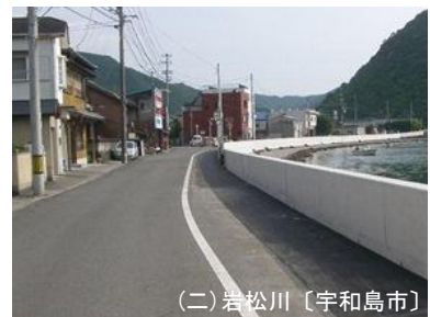
パラペット構造の特殊堤の例 (コンクリート)
