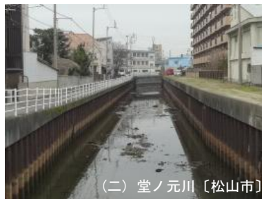
自立式構造の特殊堤の例 (鋼矢板)
