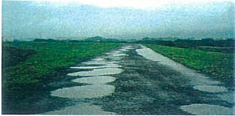
図-参 3.7 天端に生じた水たまり
