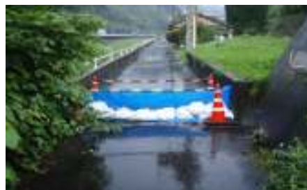
(二)千丈川右岸(郷)上流側 積み土のう工
