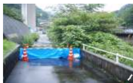
(二)千丈川右岸(郷)下流側 積み土のう工
