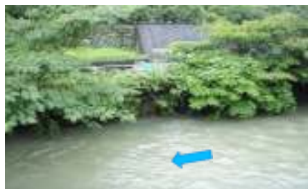
(二)千丈川右岸(郷) 河川巡視
