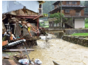
大瀬中央の浸水被害
