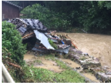
大瀬中央の浸水被害
