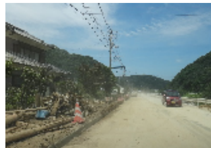
④被害状況(立岩)
