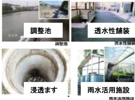
雨水貯留浸透施設の例
