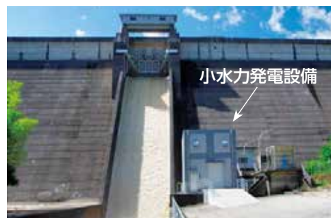
クレストゲートから放流を行っている玉川ダムと平成29年1月から運転している小水力発電設備
