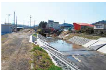
(一) 渡川水系内平ヶ谷川 広域河川改修事業（宇和島市）
