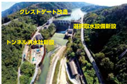
鹿野川ダム改造工事（トンネル洪水吐）
