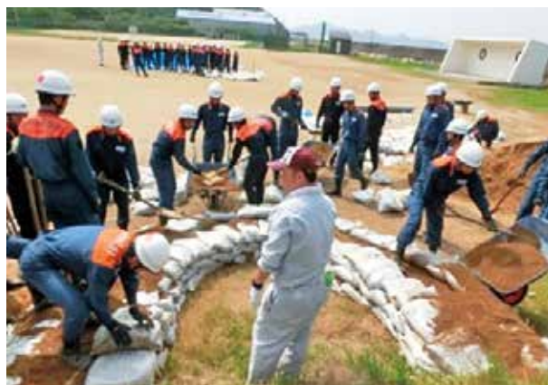
県消防学校生への水防工法指導
