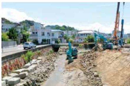
(二) 大川水系大川 広域河川改修事業（松山市）
