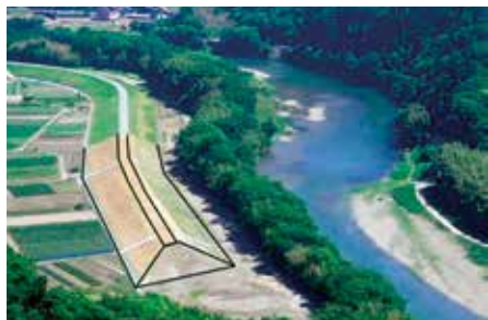
県管理区間の築堤工（菅田地区）
