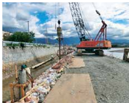
(二) 国領川（新居浜市）堤防耐震対策工事
