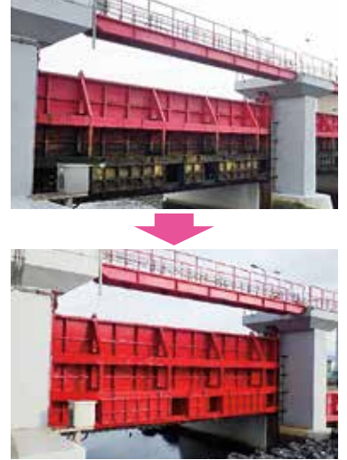
大川水門（松山市）扉体塗替え
