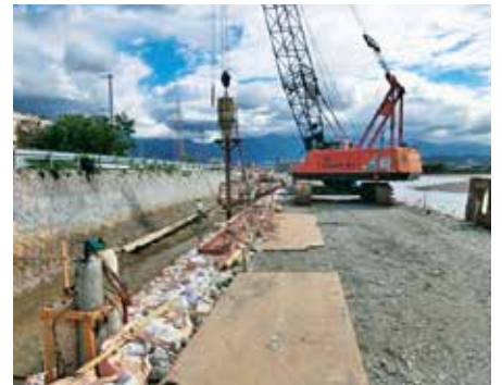
(二)国領川（新居浜市）堤防耐震対策工事(施工状況)
