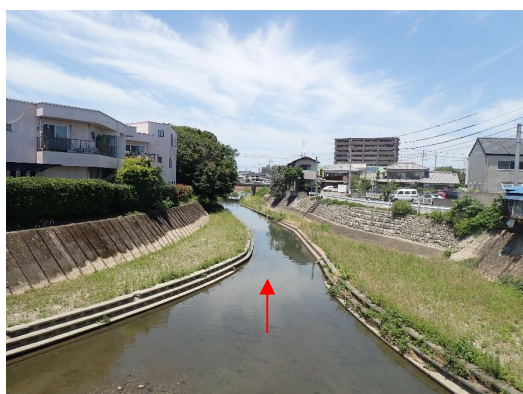
中流域の親水整備（高水敷利用と親水階段）【左：2.7k、右：3.6k】
