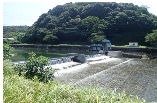
大井出堰（僧都川 4.4k 付近）
